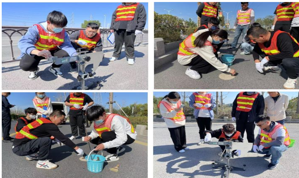
图 34 建筑工程学院学生参与临江路项目现场检测验收
